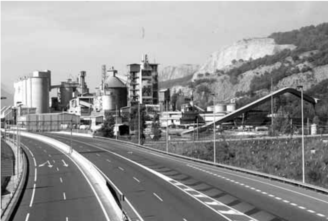
Vista exterior de la planta de Cementos Portland en Olazagutía.
